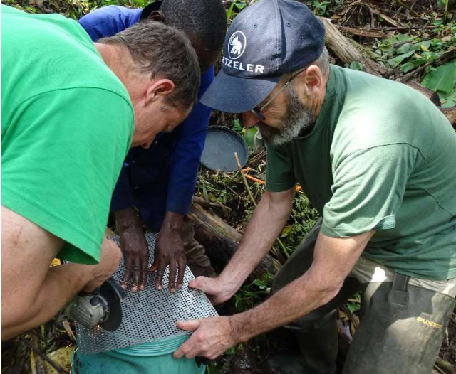
Vorbereitung für sauberen Einlauf des Pumpwassers
