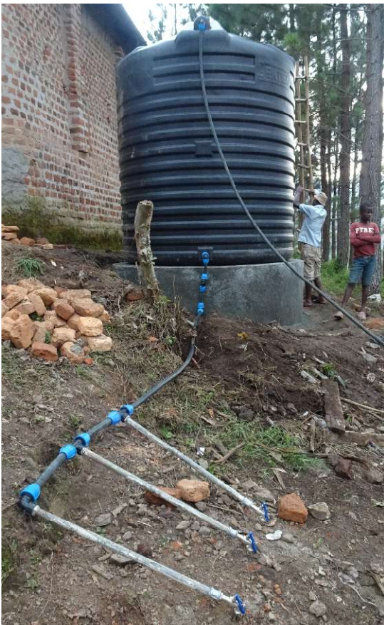
Die Wasserhähne werden noch fixiert.
