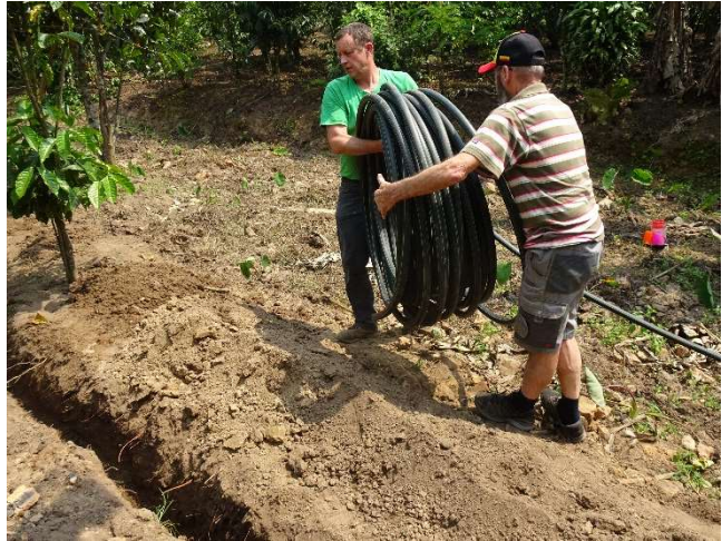
Trinkwasserrohr verlegen
