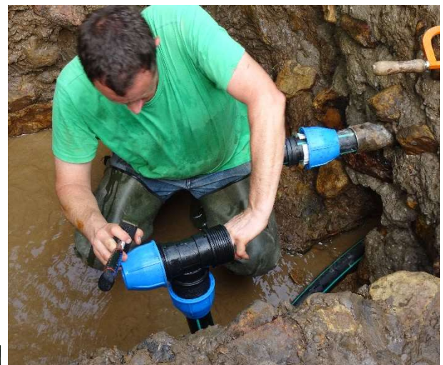
Vorbereitung des Trinkwasserbassins zur Entnahme
