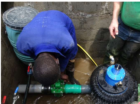
Pumpeneinbau und Einschulung
