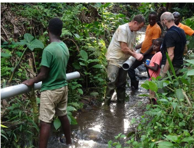
Rohre für Pumpwasser verlegen
