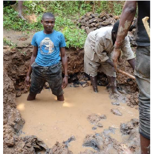
Ausheben des Pumpenschachtes
