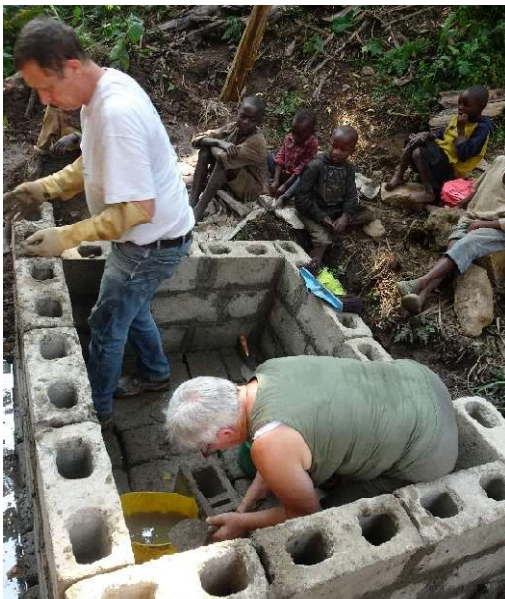
Ausheben des Pumpenschachtes
